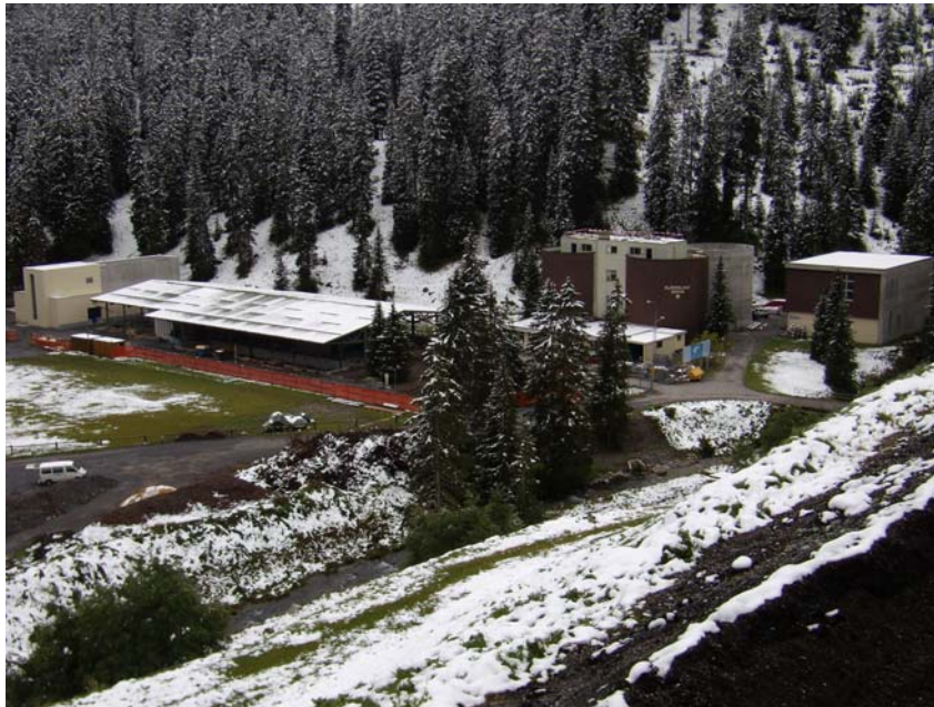
Figure 1 - STEP d'Arosa. Les Biostyrs sont situés dans le bâtiment couleur crème
