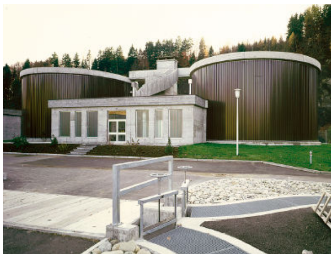
Installation de digestion de Broc (FR)
