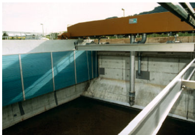
Bras suceur ALPHA-TOW/BRO dans un bassin rectangulaire, STEP de la Verna (VD)
