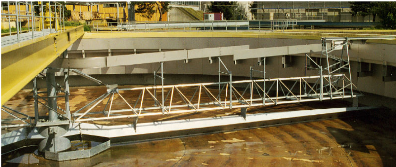
Bassin circulaire avec bras suceur ALPHA-TOW/BRO, intégré lors de l'assainissement de la STEP de Bienne (BE)
