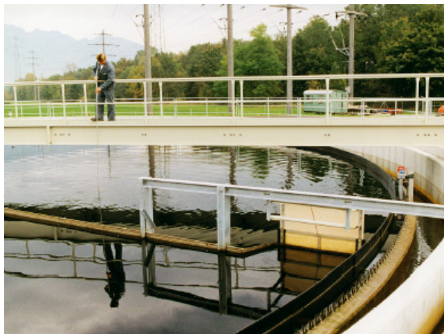
Rigole de sortie et installation de raclage, STEP de Buchs (SG)
