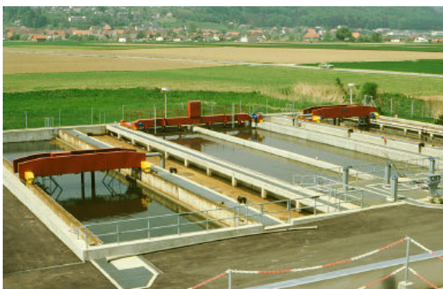
Bassins rectangulaires à courant transversal, STEP d'Orpund (BE)
