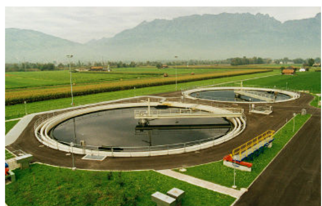
Bassins circulaires avec alimentation et évacuation périphérique, STEP de Buchs (SG)
