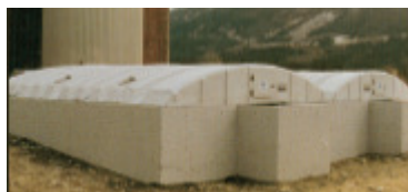
Installation couverte de disques biologiques
