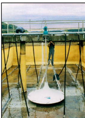
Montage d'un agitateur HYPERCLASSIC® (sans palier sur le radier du bassin)
