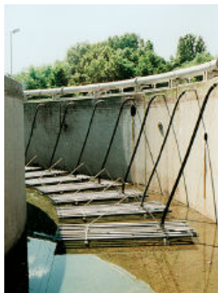
Diffuseurs d'air à membranes RK installés de manière relevable dans un bassin circulaire
