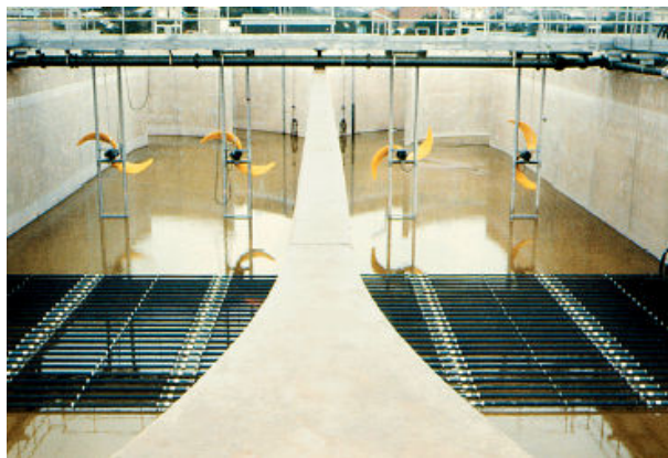
Diffuseur d'air à membranes RK dans un bassin
