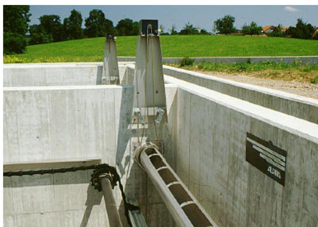
Récupération des flottants par tube écumeur motorisé situé à la sortie du décanteur primaire
