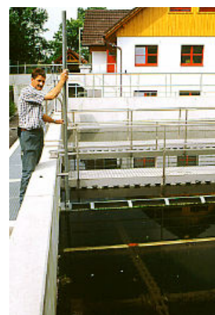
Tube écumeur à rotation manuelle
